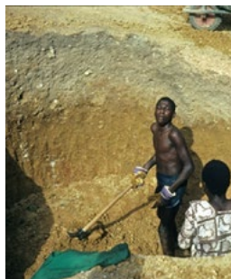
Bau der Biogasanlage
