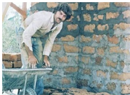
Bau der Schmiede
