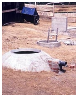
Fast fertige Biogasanlage
